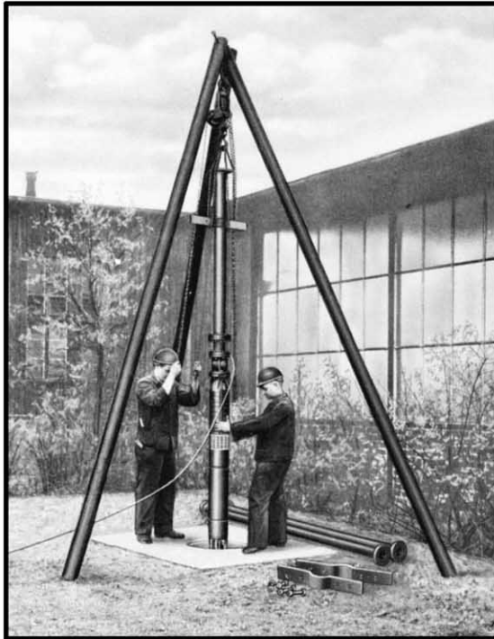
شکل ۱۷- روش نصب الکتروپمپ شناور
